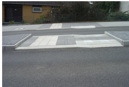
Bild 4: Mittelinsel in Nähe einer Bushaltestelle, errichtet als getrennte Querungsstelle aus dem Bordsteinsortiment der Firma Profilbeton GmbH Borken (Fulda, Febr. 2008)
