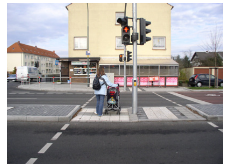
Bild 5: Getrennte Querungsstelle mit LSA, Randeinfassung errichtet mit konventionellen Bordsteinen (Fulda, 2007)
